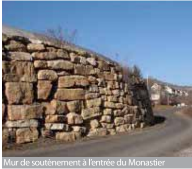
Mur de soutènement à l'entrée du Monastier
