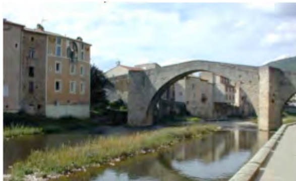
Pont Vieux, St Affrique
