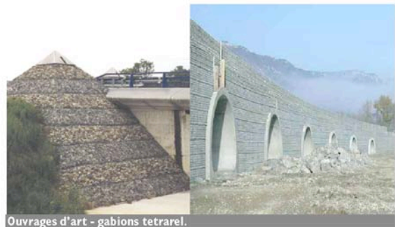
Ouvrages d'art - gabions tetrarel.
