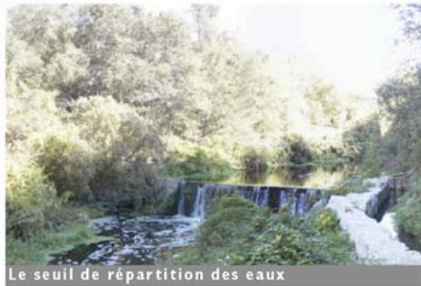
Le seuil de répartition des eaux
