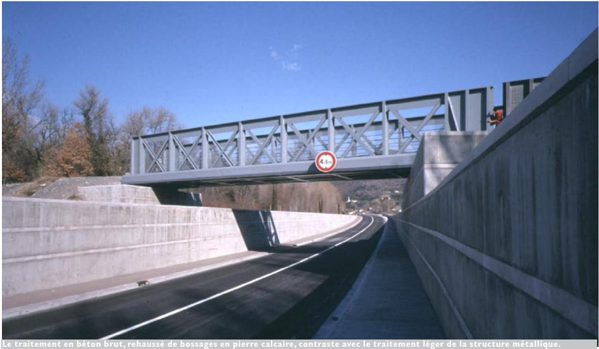
Le traitement en béton brut, rehaussé de bossages en pierre calcaire, contraste avec le traitement léger de la structure métallique.
