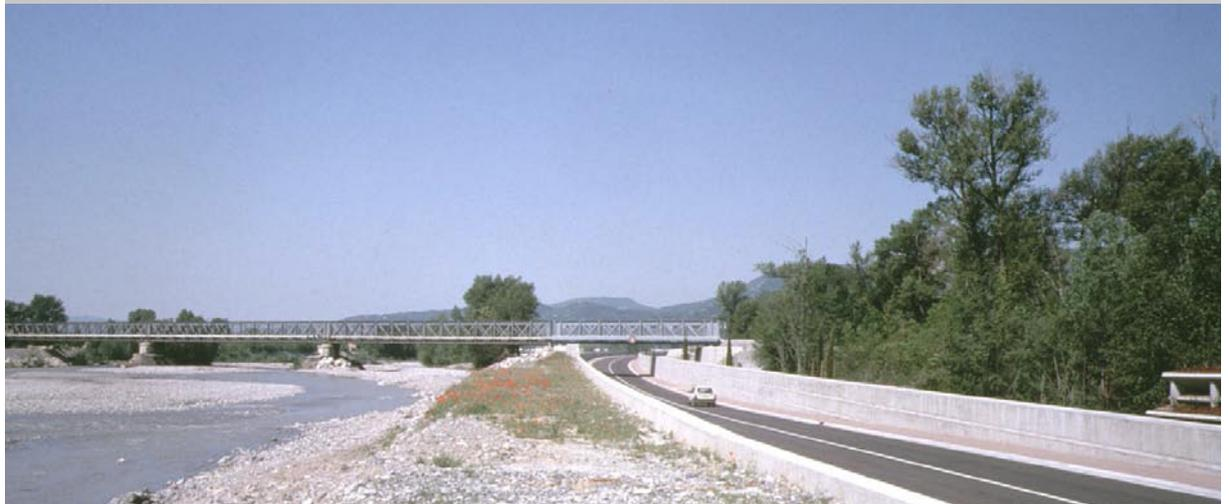
La nouvelle trame du pont est réalisée à l'identique, c'est-à-dire par des poutres treillis d'un même gabarit que celles existantes.
