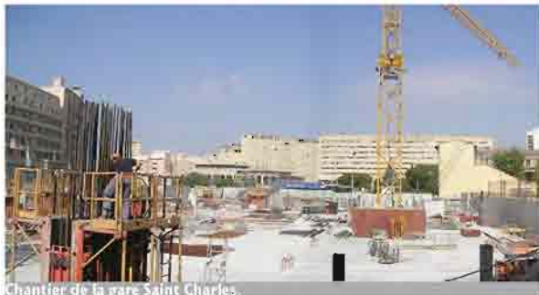
Chantier de la gare Saint Charles.
