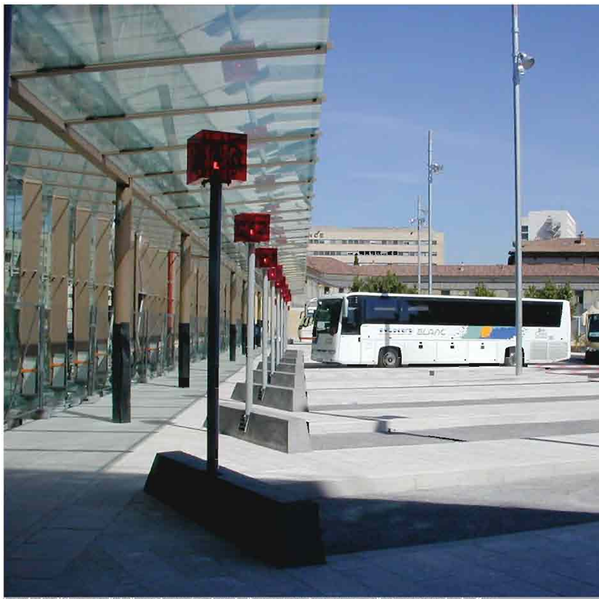
La seule signalétique est celle indiquant les numéros de quais, d'une part pour les voyageurs, et d'autre part pour les chauffeurs.
