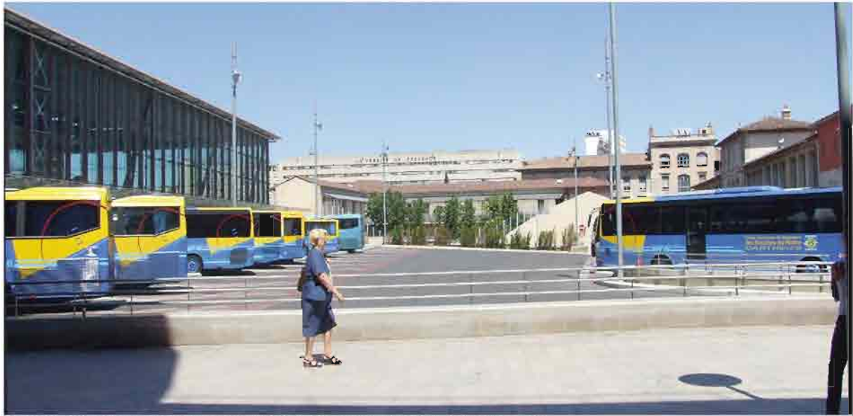
En sortant de la gare, un grand espace ouvert et le long banc muret qui protège de l'espace routier
