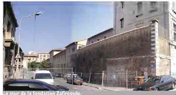
Le mur de la fondation Zafiropulo.
